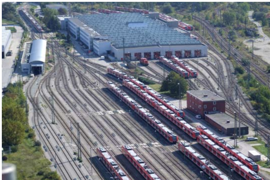
Vogelperspektive: Im Betriebswerk Steinhausen werden vier verschiedene Baureihen und über 311 Triebzüge gewartet und instandgesetzt. In den nächsten fünf Jahren soll das Werk Schritt für Schritt modernisiert werden.
