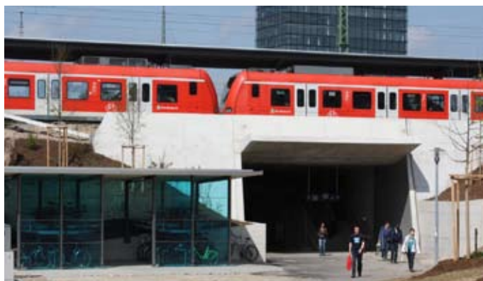
Berg am Laim: Der barrierefreie Ausbau der Station im Münchner Osten soll noch in diesem Jahr komplett abgeschlossen werden.
